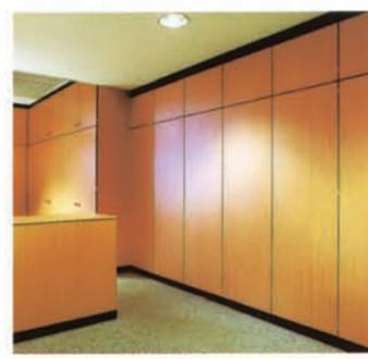
Schrank- und Trennwände müssen nahtlos kombinierbar, Vollwandelemente und Glaselemente und Türen gegeneinander austauschbar sein. Hohe Stabilität, gute Schalldämmung, Feuerschutz nach DIN 4102, bei zeitlosem Design sind Selbstverständlichkeiten umsetzbarer Wandsysteme.
